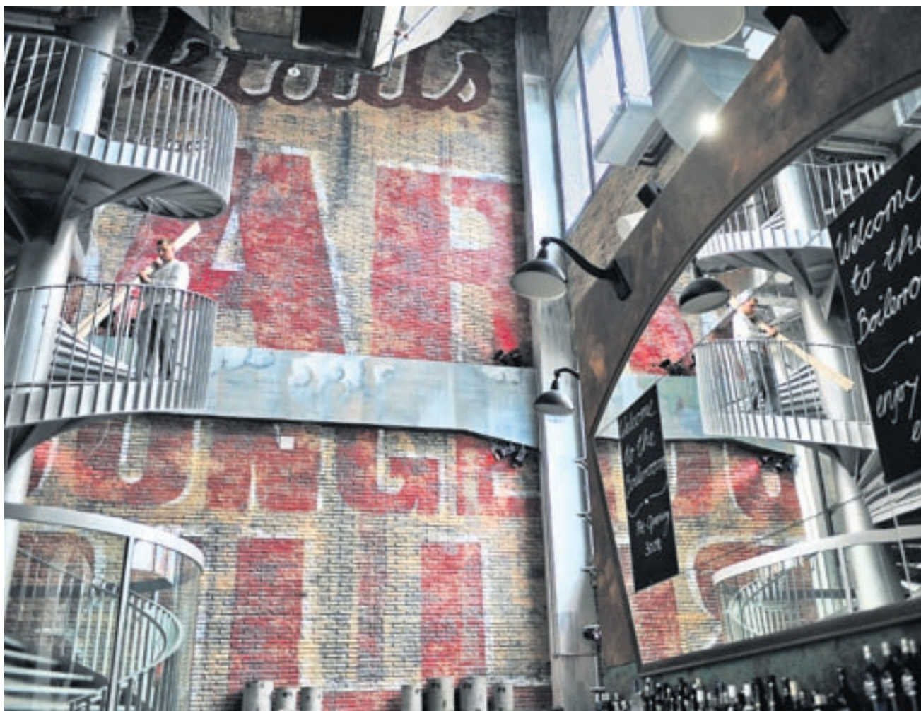
Das alte Sulzer-Kesselhaus wird morgen neu eröffnet. Herzstück ist die Bar mit den früheren Kohlesilos (oben sichtbar). Bild: mad
